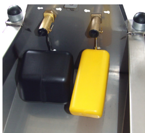
Fénykép a pluszban felszerelt alacsony nyomású úszószelepről (sárga színű)
