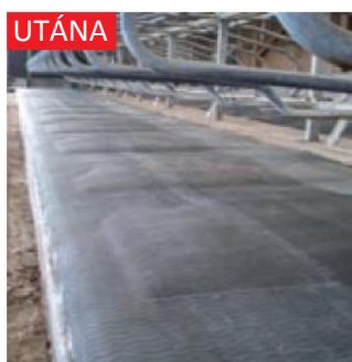
Felújítás az Aquatop lerakásával
